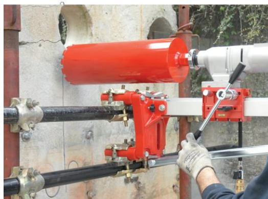
Ancoraggio supporto a ponteggio
