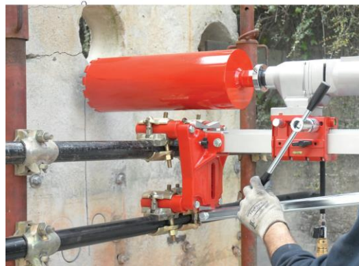
Ancoraggio supporto a ponteggio
